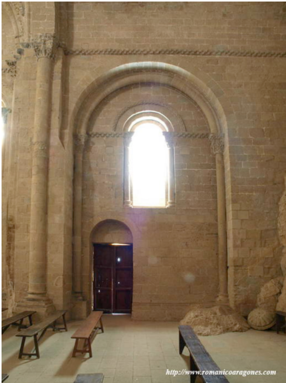
Fig. 11. Loarre. División en "V" de pilastra.
