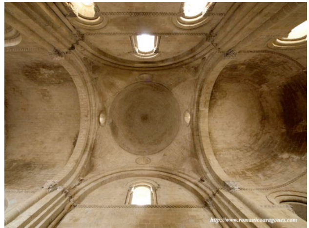
Fig. 7 San Pedro de Loarre. Bóveda
